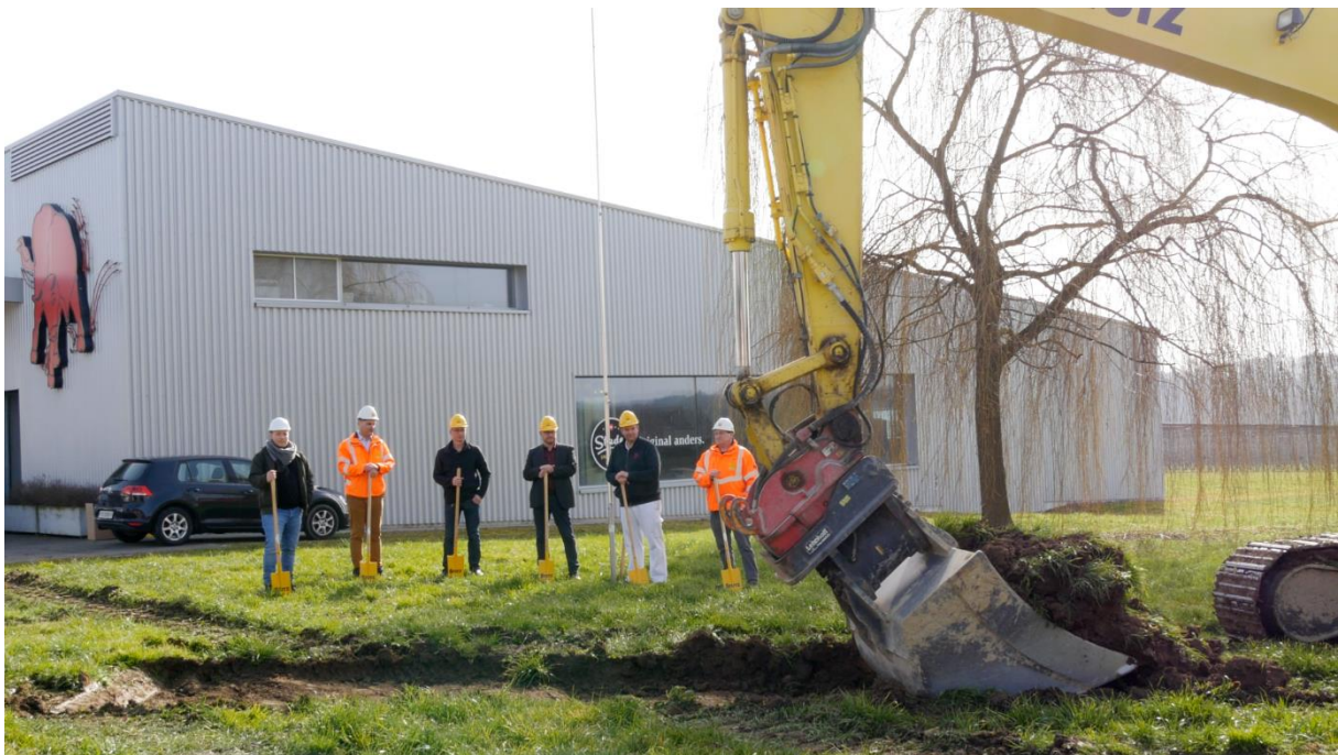
Bildlegende: Spatenstich zum Ausbau 26.2.2021
